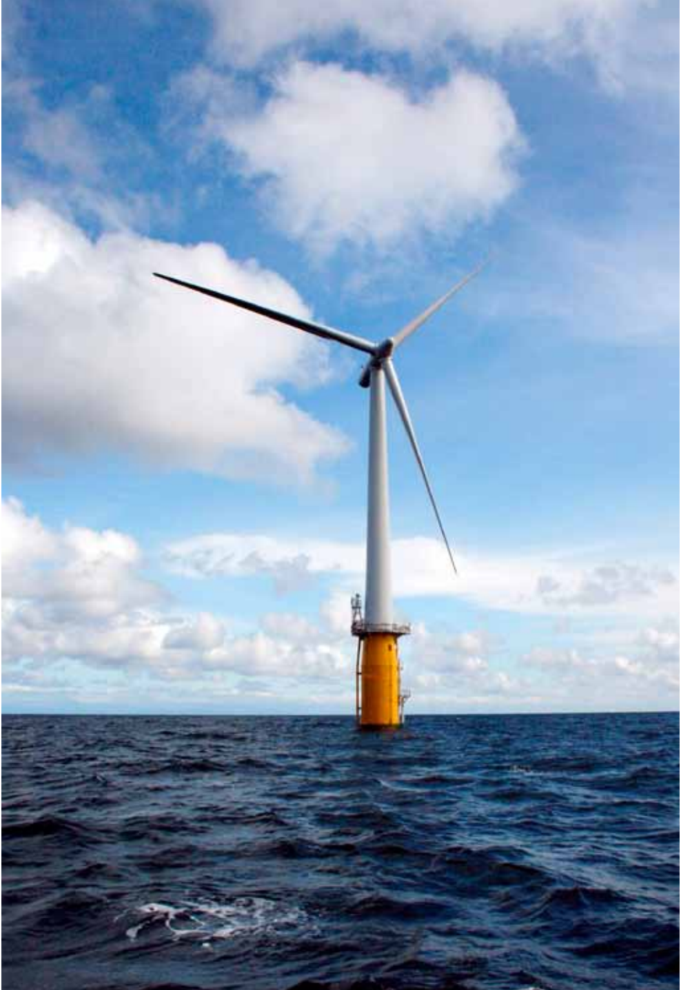
Statoils Hywind-turbin utenfor Karmøy er den første flytende vindturbinen i verden. Foto: Trude Refsah/Statoil
